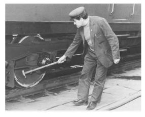
Asimismo, el visitador se encargaba de comprobar el buen estado de los medios auxiliares, como calefacción o iluminación, incluso hacía pruebas de freno y cambiaba zapatas, también comprobaba la temperatura de los cojinetes de los ejes y de las cajas de grasa y, ayudado por una "plantilla de visitador", comprobaba deterioros de pestañas por el rozamiento en las ruedas y los posibles planos.
