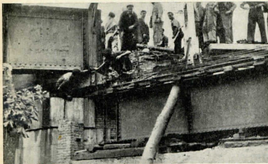
El nuevo puente durante su colocación.
