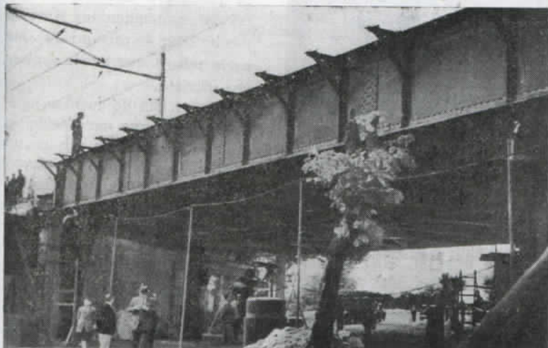
El puente viejo por su parte inferior.
