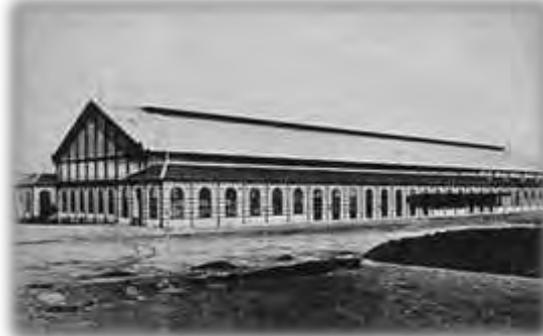
*El sistema de construcción empleado es el que se siguió en las galerías de máquinas de la Exposición de París en 1878, siendo también iguales las dimensiones en latitud y alturas, y está formada por 18 cuchillos de armadura que arrancan desde la cimentación, espaciados entre sí 10 metros y con un cuerpo de luces que corre por los muros laterales, a ocho metros de altura, y se desarrolla en una superficie de 1.800 metros.*
